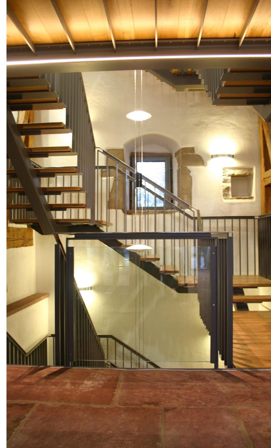
**Abbildung:** 1. Dachgeschoss mit Blick auf die Treppe ins 2. Dachgeschoss Richtung Festsaal. Die notwendige Raumteilung ist auf gläserne Abtrennungen reduziert. Die Glashalteleisten sind eigens für die Zehntscheune entwickelt worden.
