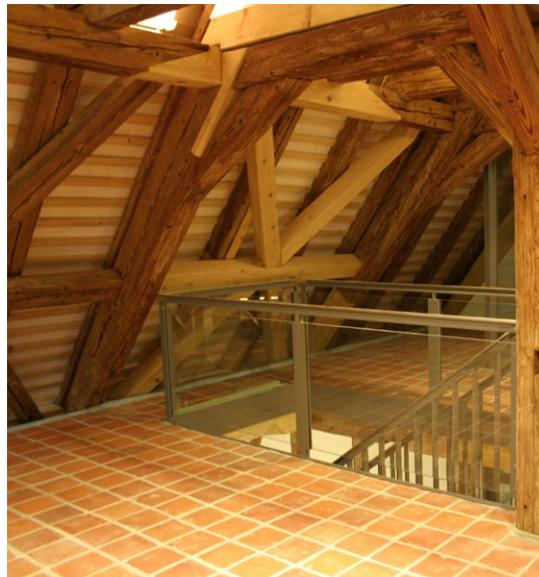
**Abbildung:** 2. Dachgeschoss mit den wiederverlegten Terrakotta-Platten im Flur
