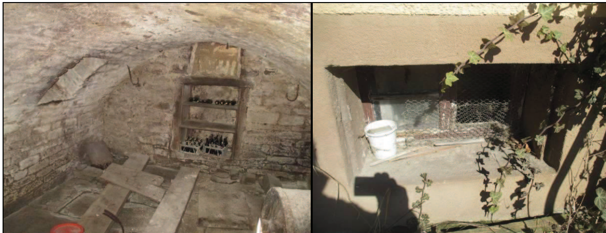
Abbildung 5 Gewölbekeller (links) und Außenansicht des vergitterten Fensters zum Gewölbekeller (rechts).
