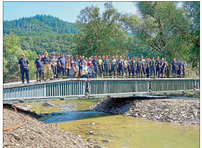
Feuerwehrlaute aus dem Enzkreis haben beim Bau einer Behelfsbrücke im Katastrophengebiet in Rheinland-Pfalz mitgeholfen. Foto: enz / Fotografin: Ines Jeitner
