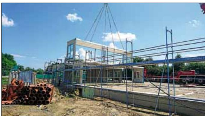
*Mit diesem Bild wird klar, was einen Modulbau ausmacht*
