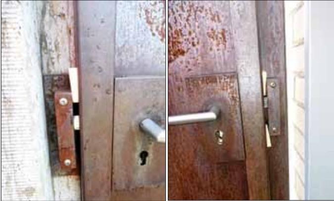
Bei genauerer Betrachtung stellte sich heraus, dass die Tore nicht abgeschlossen waren, sondern mittels (fachmännisch) eingeschlagener Holzkeile so blockiert waren, dass diese nicht mehr geöffnet werden konnten.
